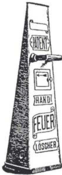
Zwischenzeitlich brachte 1884 Schwartz in Bocholt den „Patent-Handfeuerlöscher“ in Form eines Wurfeimers mit flacher Schnauze auf den Markt, der auf Grund seiner spitz verlaufenden Schüttöffnung einen gezielten Strahl ermöglichen sollte. Wie aus der Abbildung zu entnehmen, besaß diese Konstruktion eine Ähnlichkeit einem heute noch bekannten Koks- oder Steinkohleschütteimer, der in einigen Gebieten noch heute Anwendung findet.
